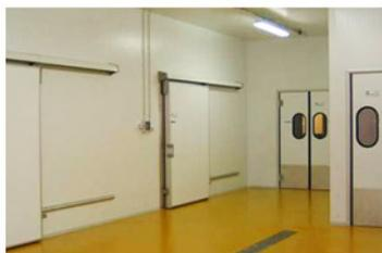
Il pannello metallico coibentato è qui progettato per garantire isolamento termico nella costruzione di celle frigorifere industriali e altri ambienti refrigerati.
